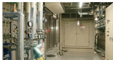
自家発電機を設置
