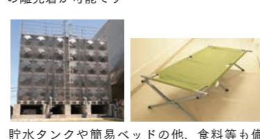
貯水タンクや簡易ベッドの他、食料等も備蓄しています
